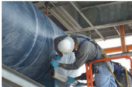
Aplicación de tela de malla
