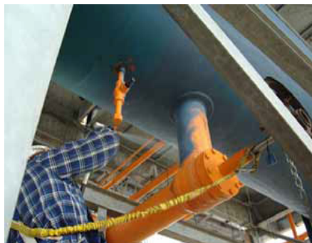
Pulverización del tanque
