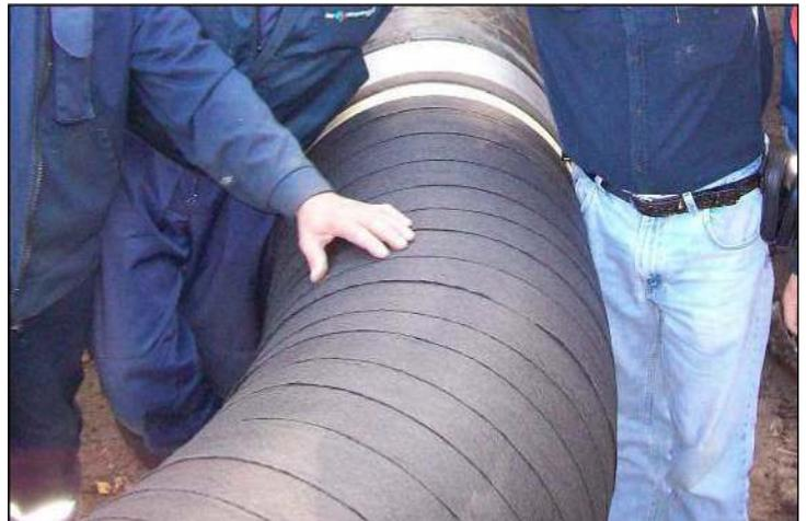
O **SP-6™** reduz a deformação dos sistemas de revestimento anticorrosivo causada pelo estresse do solo. Ele age como um plano deslizante para aliviar o estresse do solo.
