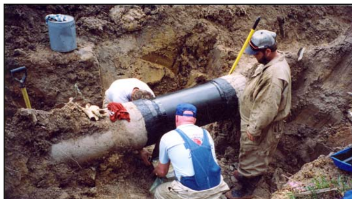
Le Ruban Mastic 606 peut remplir les transitions irrégulières évitant ainsi les trous sous le revêtement.
